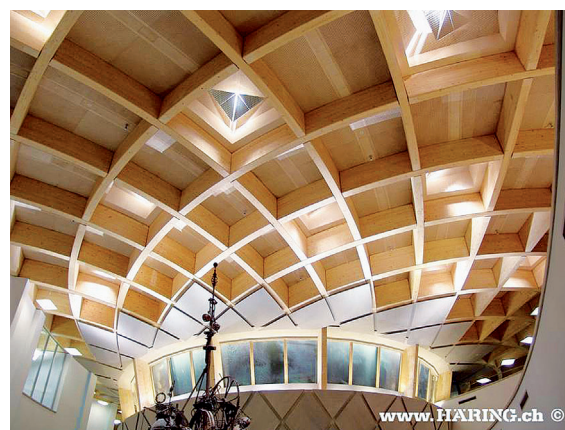
Abbildung 24. Salzlagerrhalle aus Brettschichtholz ( http://www.haring.ch ).
